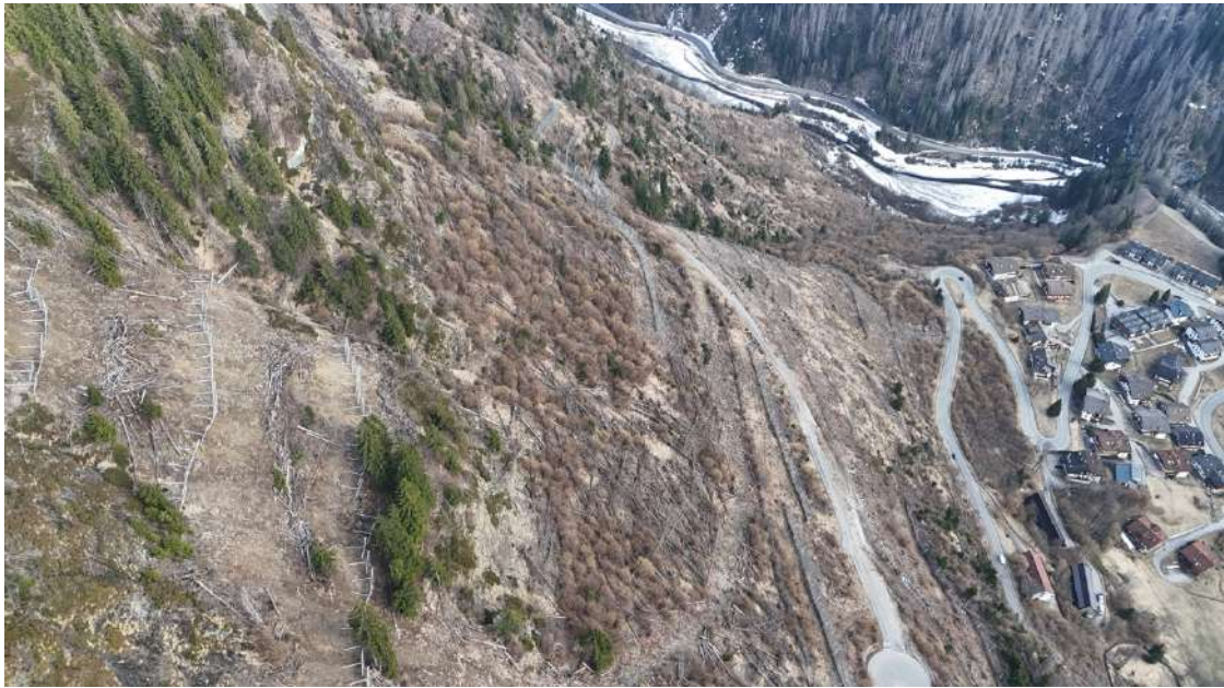
Figura 8 - interventi di messa in sicurezza da valanghe pot Vaia. Esecuzione Veneto strade spa.
