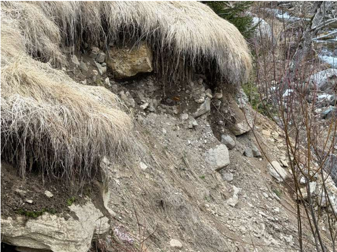
Figura 4 - Deposito affiorante a valle del sito. Ghiaie con trovanti in matrice sabbiosa.
