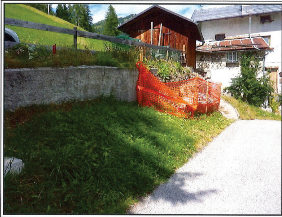
FOTO 1: VISTA MURO A CONFINE CON LA VIABILITA' COMUNALE
