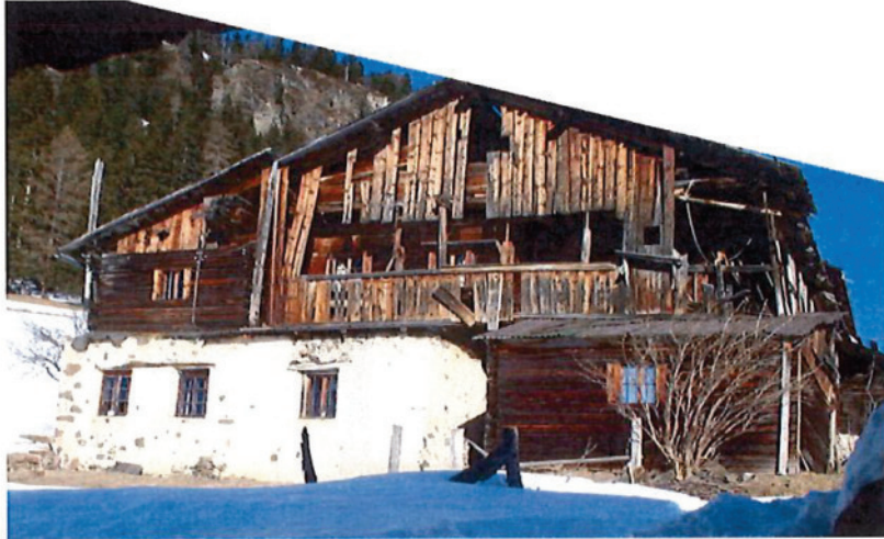
PROSPETTO SUD FOTO STORICA
