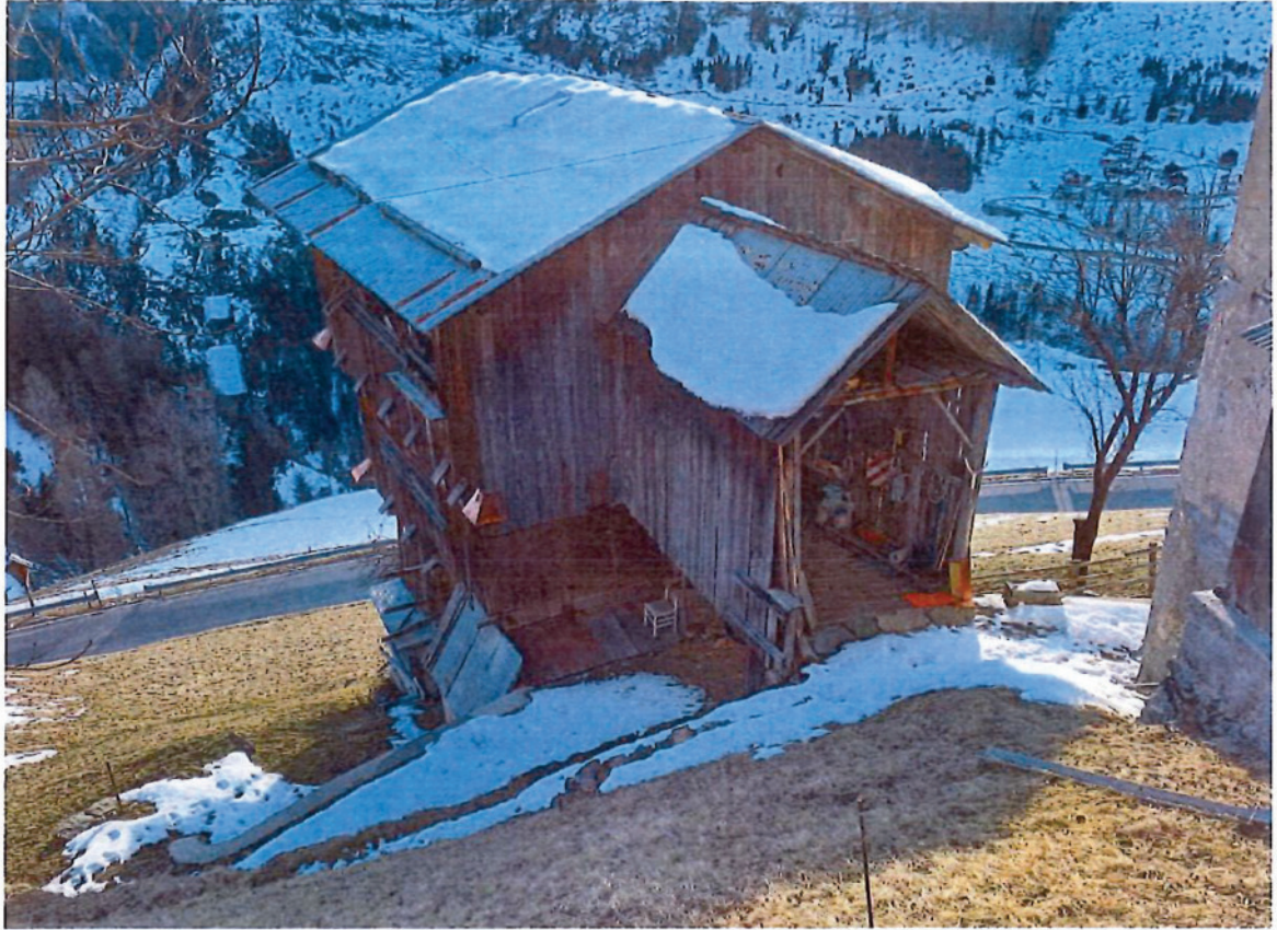
Mason in loc. Rucavà con copertura sul ponte di accesso a monte;
