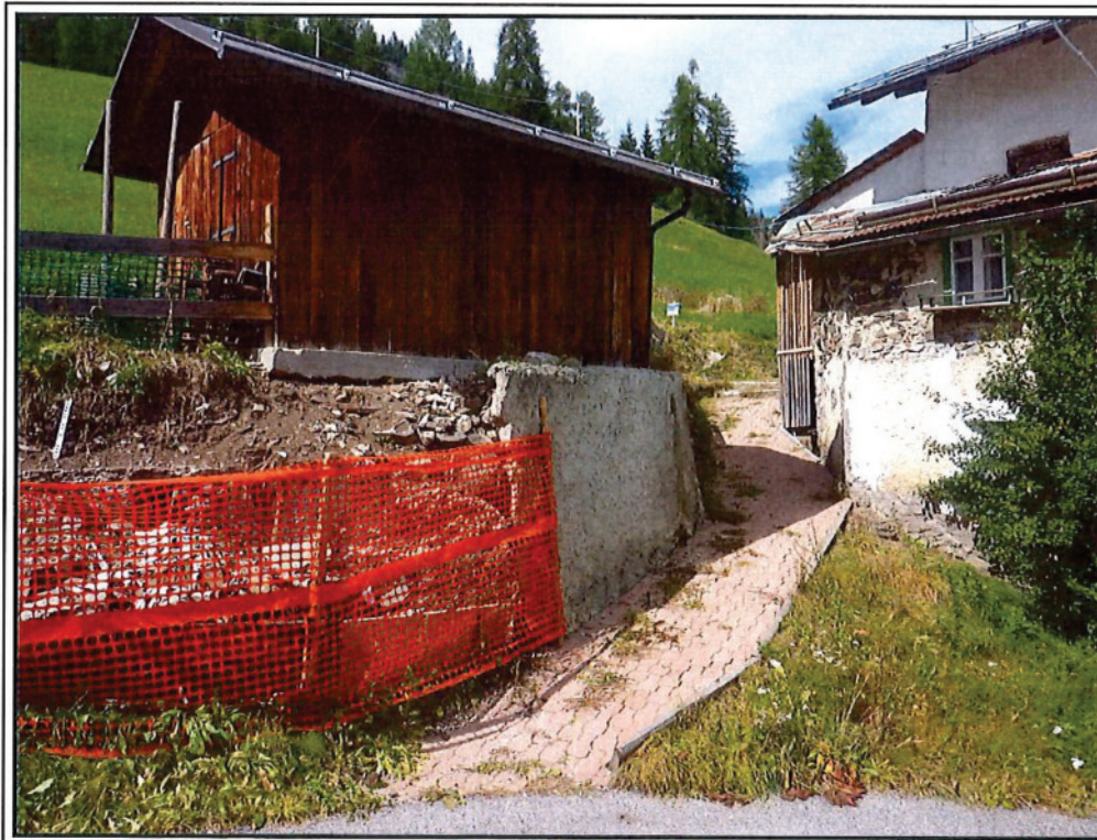
FOTO 2: VISTA ZONA DI ACCESSO PEDONALE ALL'INGRESSO POSTERIORE DELLA CASA
