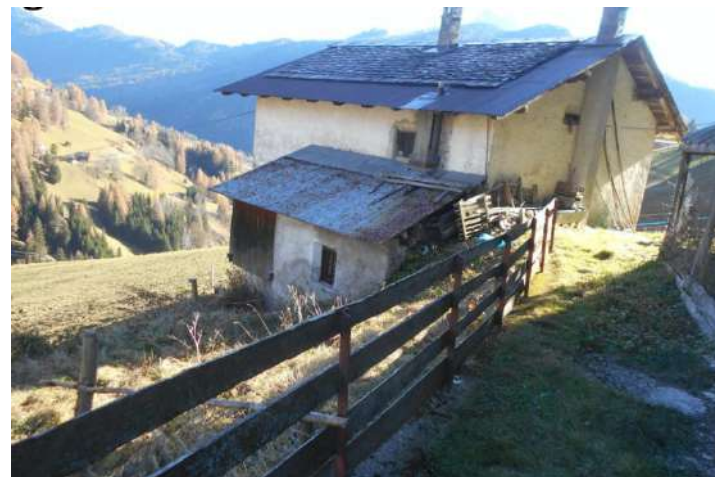
Vista dell'edificio esistente da recuperare, ripresa dall'attuale percorso, che si prevede di allargare per dare luogo allo spazio di accesso e sosta auto.
