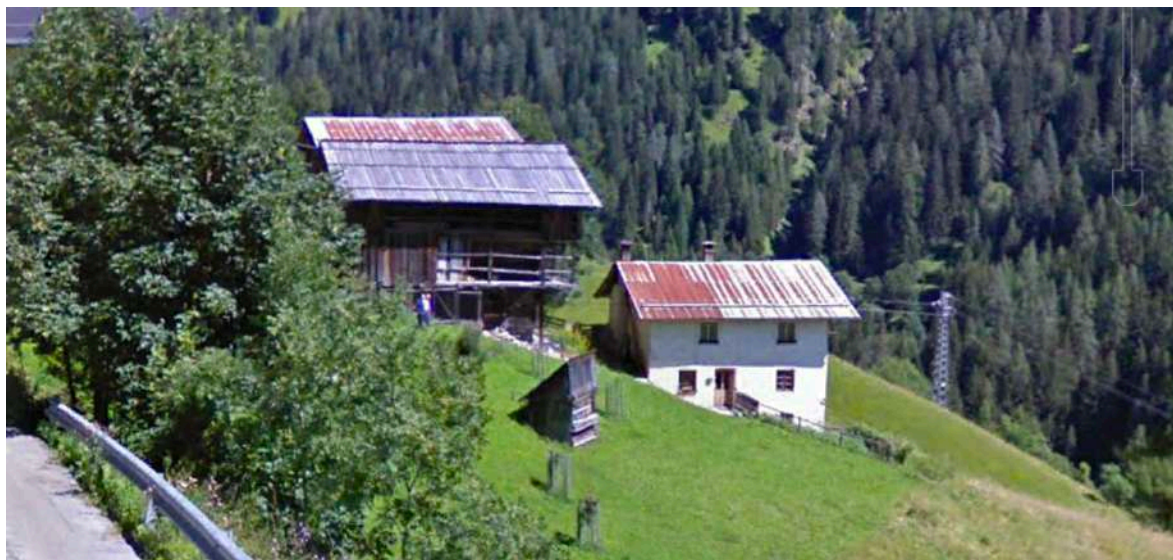
Vista da sud del complesso di case. Il fronte sud non viene alterato dall'intervento previsto, salvaguardando il rapporto diretto degli edifici con i prati circostanti
