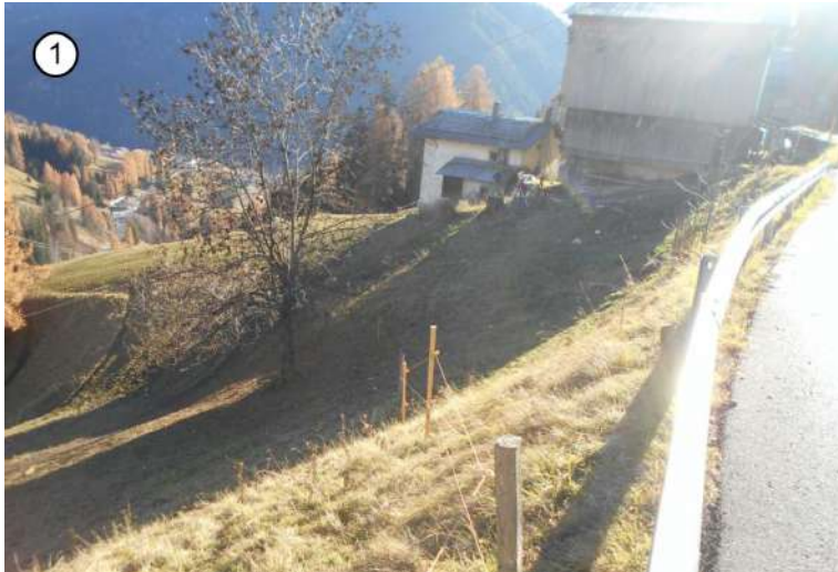
La prevista zona di innesto del percorso sulla strada esistente. In particolare, sono visibili il fabbricato e – sulla destra - il fienile, a valle del quale si prevede di realizzare uno spazio per accesso la sosta delle auto.
