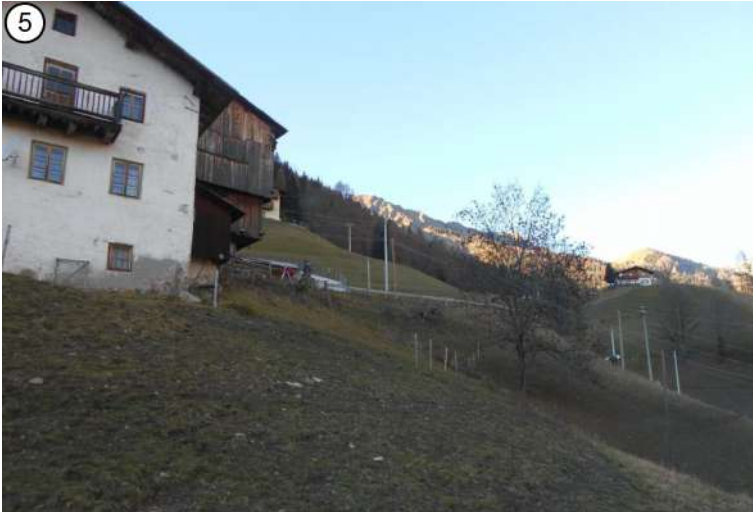
Vista "da valle" della zona di intervento.
