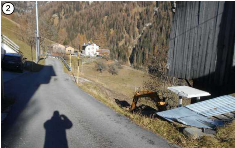
Vista della strada comunale e dell'innesto del percorso esistente oggetto dell'intervento.
